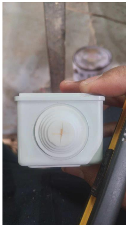
รูปที่ ก.16 กรีดเพื่อสร้างช่องให้สายไฟเข้าได้ และออกได้
