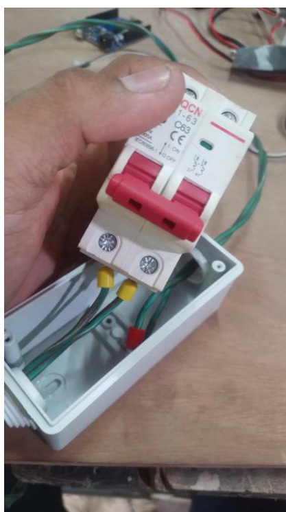
รูปที่ ก.20 นำสายไฟจากปลั๊กตัวผู้มาต่อไฟขาเข้า และชั้นน็อตพอดึงมือ
