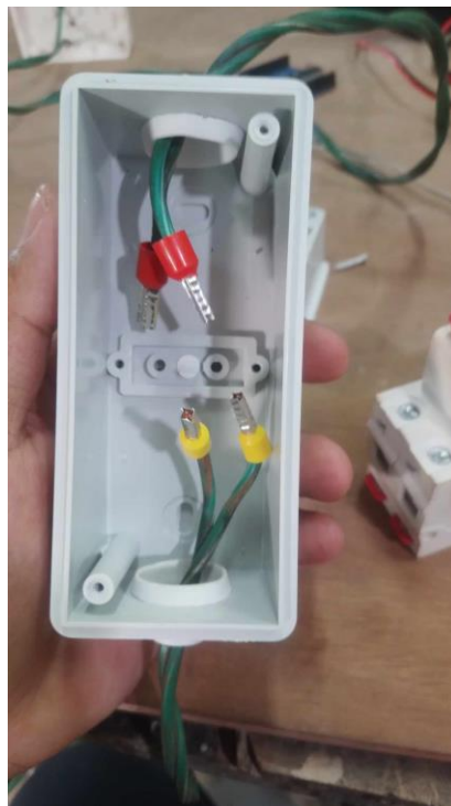
รูปที่ ก.18 นำสายไฟจากปลั๊กตัวเมียเข้ามาในกล่อง
