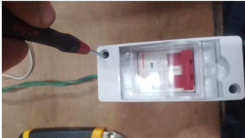
รูปที่ ก.24 ใส่สกรูจากนั้นขันพอตึงมือ
