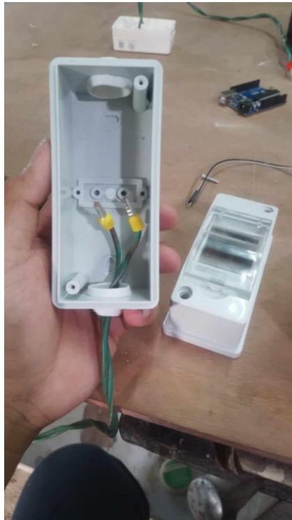
รูปที่ ก.17 นำสายไฟจากปลั๊กตัวผู้เข้ามาในกล่อง
